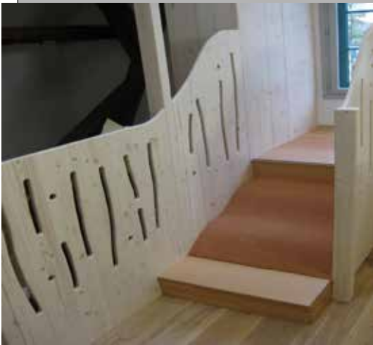
Podest im gesicherten Fensterbereich Beobachtung von oben
